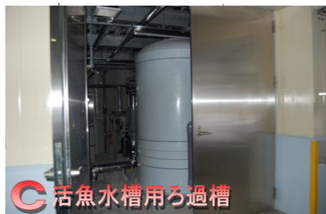
C 活魚水槽用ろ過槽 ~活魚水槽の水を循環し、常に清浄を保つ
