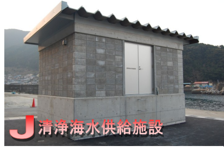
清浄海水供給施設 ~生鮮魚介類に使用するUV殺菌海水を供給
