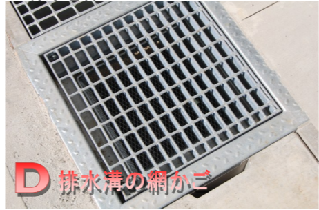
D 排水溝の網かご ~岸壁の排水溝の各所に網かごを設け、定期的に清掃
