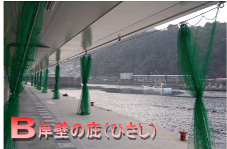
B 岸壁の庇(ひさし) ~水揚げの際、日差しや風雨等から漁獲物の品質低下を防ぐ
