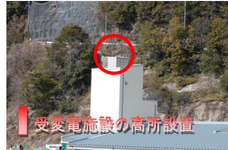
受変電施設の高所設置 ~津波対策のため受変電施設を製氷棟の屋上14.5m地点に設置
