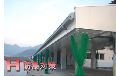
H 防鳥対策 ~鳥類の施設内への侵入を防ぐためネットやワイヤー等を設置
