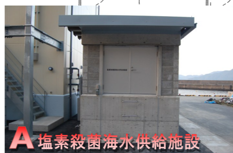
A 塩素殺菌海水供給施設 ~床面洗浄や長靴洗浄槽等に使用する塩素殺菌海水を供給
