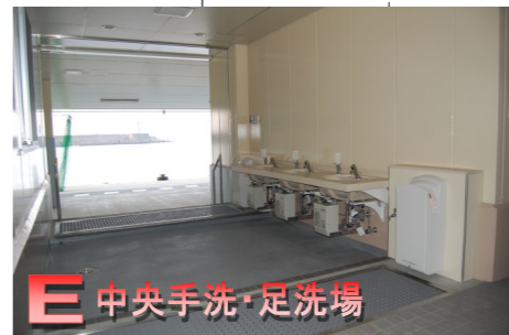
E 中央手洗・足洗場 ~衛生管理エリアへの入場の際は必ず手洗い、長靴消毒を行なう
