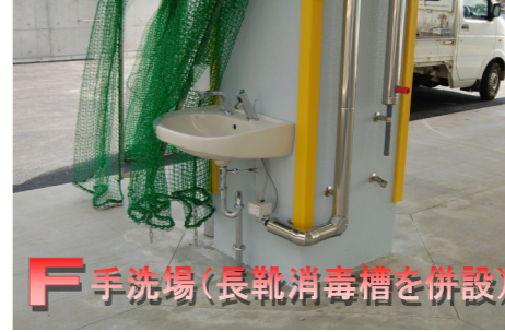
F 手洗場(長靴消毒槽を併設) ~衛生管理エリアへの入場の際は必ず手洗い、長靴消毒を行なう
